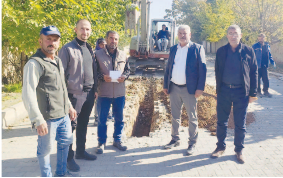
Afyonkarahisar'ın Işıklar beldesinde doğal gaz yatırımı kapsamında 3. etap hat çalışmaları Yeni Mahalle'de başladı
