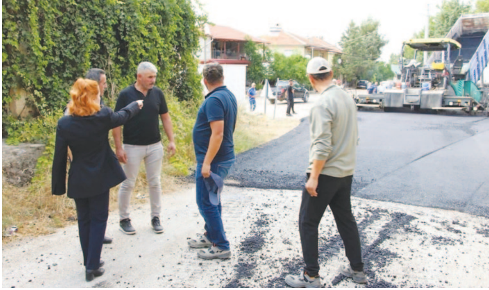
İncelemelerde bulunan Kaymakam Bayrı, yol yapım süreci, gerçekleştirilen çalışmalar ve projenin ilerleyişi hakkında yetkililerle görüş alışverişinde bulundu.
